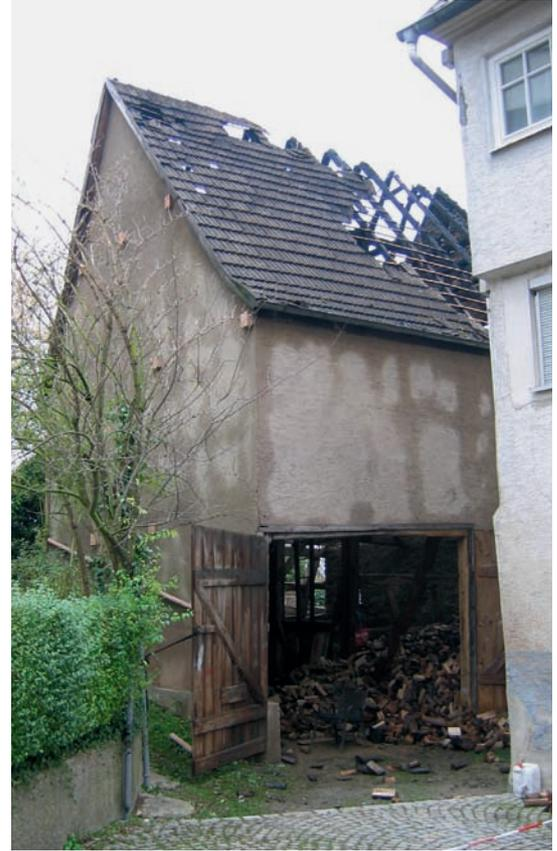
*Scheunengebäude zur Keltergasse 5, frisch abgelöscht nach einem Brand im November 2004. Wegen starker Schäden anschließend abgebrochen.*
